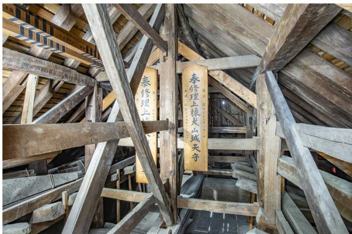
写真3 三重目小屋裏(屋根裏)(麓 和善 撮影) 三重小屋裏の当初材は、いずれも一・二重の当初材と同様の加工痕である。
